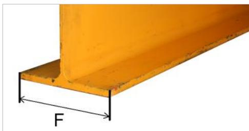
➔ Mesurer la largeur F de l'aile de la poutre en I.
